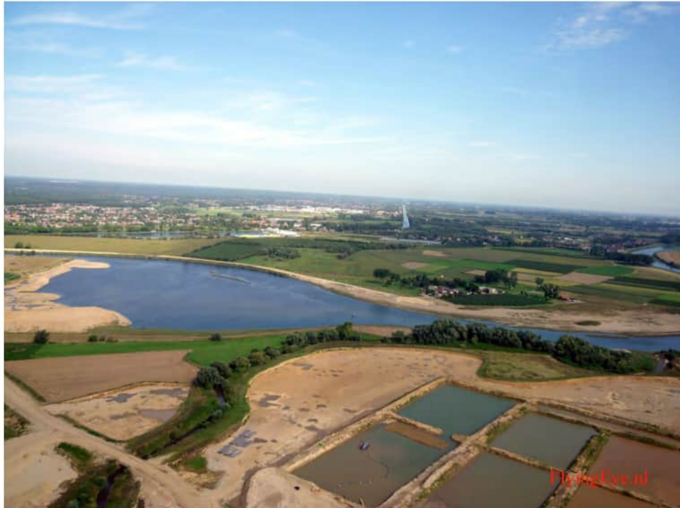
Foto 2.1: De weerdverlaging bij de Itterense weerd in de Grensmaas pakte, mede door de benedenstrooms gelegen drempel, anders uit dan in het oorspronkelijke ontwerp beoogd was: er ontstond een grote watervlakte in plaats van een reliëfrijke oever (links boven). Voor deel twee van de uitvoering is dan ook een aangepast ontwerp gemaakt (foto: Consortium Grensmaas).
