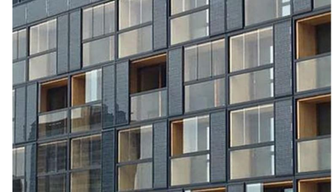
Gevel met PV-panels
